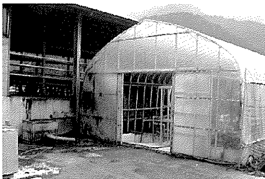
写真1 浄化処理施設前全景
