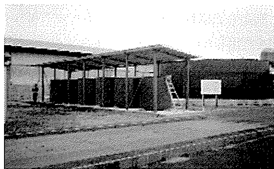
処理施設の全景
