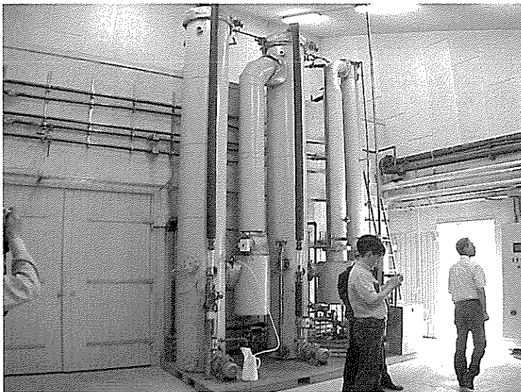
写真5 Hegndalの個別型バイオガスプラントの消化液を成分分離するエバポレーター。発電動機を冷却した水の熱で減圧蒸発させることで、低コストで蒸発させることができる。
