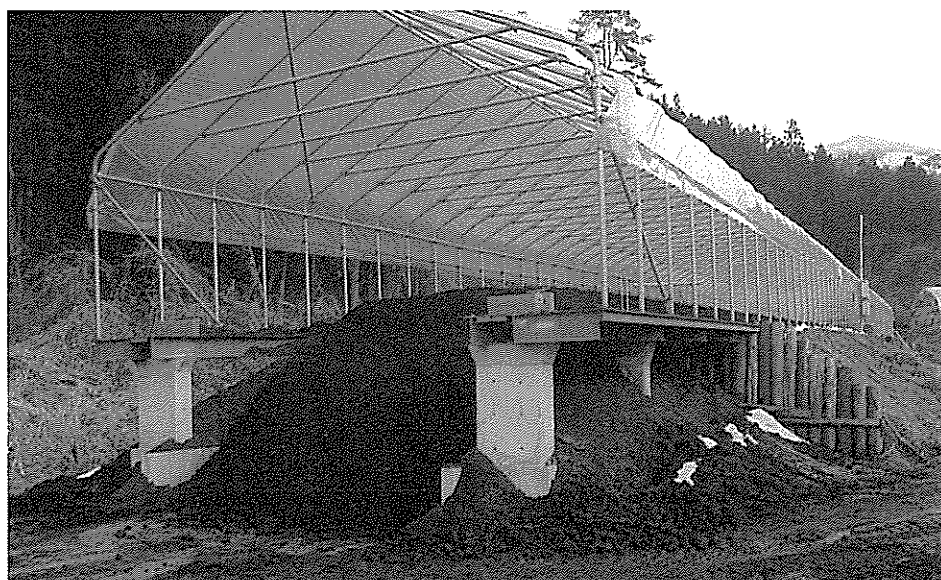
写真1 ピットの設置状況
