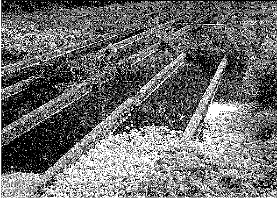
写真8 コンクリート製の人工水路：高さ18cm、幅1m、全長750mの施設を処理水が流下する。8か月前に、施設内に沈殿した汚泥、繁茂した水生植物等を除去したため、パロットフェザーが僅かにみられる程度であり、浄化機能は低い（宮城県高清水町T牧場）。
