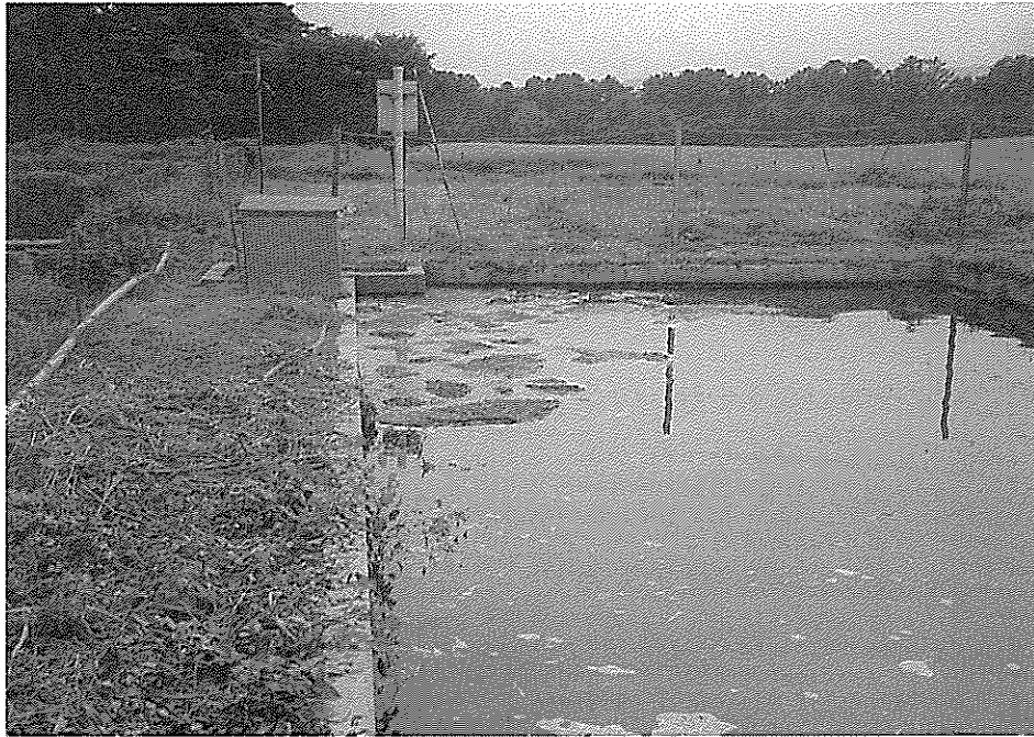
写真1 試料採取時における曝気池の状況 (スカムの浮上が認められる)
