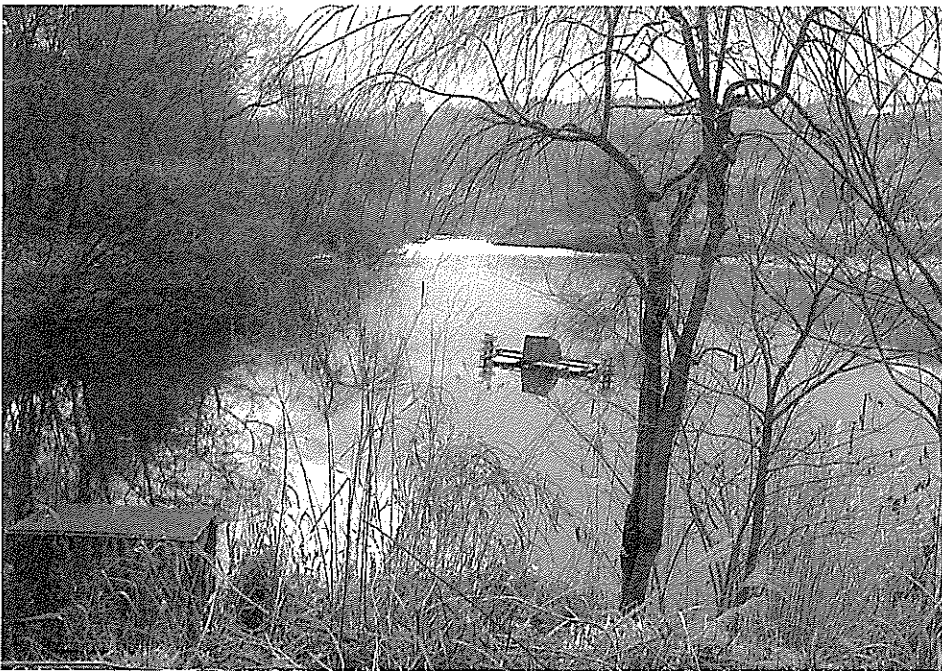
写真7 水生植物がみられない池：複合ラグーンシステムによる処理を行った後、処理水を最初に放流する池。余剰汚泥等の沈殿物が多く、5年に一度の頻度で浚渫を実施している。水深が深く、水生植物の定着もみられず、浄化機能はあまり高くない（宮城県高清水町T牧場）。
