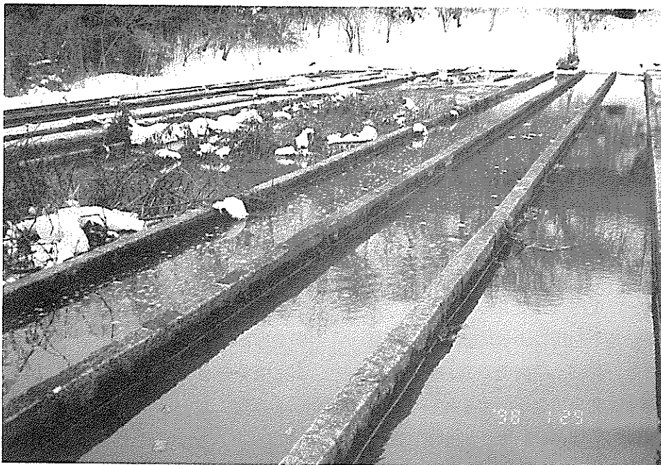
写真8. コンクリート製の人工水路。面積750㎡、総延長距離750mで、水深は最高が18cmで、水量が少ないばあいには、数cmの水深となる。平成9年春に清掃を行い、水草を全て除去している。通常は多数の水生植物が水路を埋め尽くしており、高度の浄化機能が期待できる（宮城県高清水町）。
