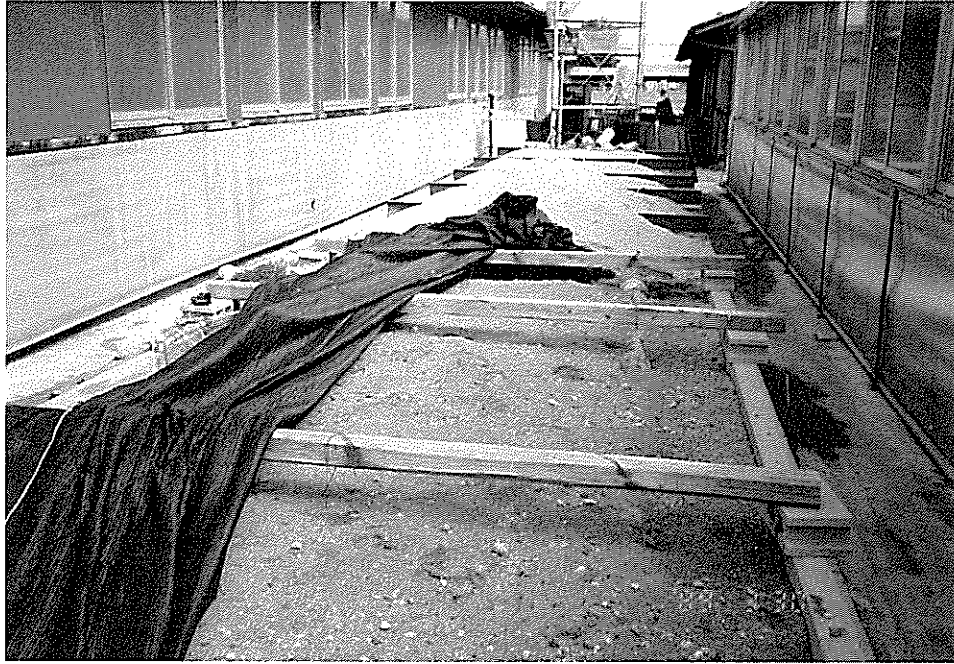
写真1. ホーリアクター。リアクターには多孔質化された木質細片を詰め ており、微生物の作用を利用して浄化を行う。施設はコンパクトであり、豚 舎間の狭い空き地にも設置可能である（福島県鏡石町）。
