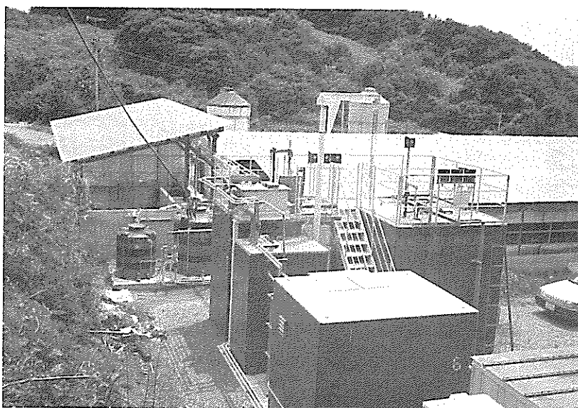
写真4 プラント全景
