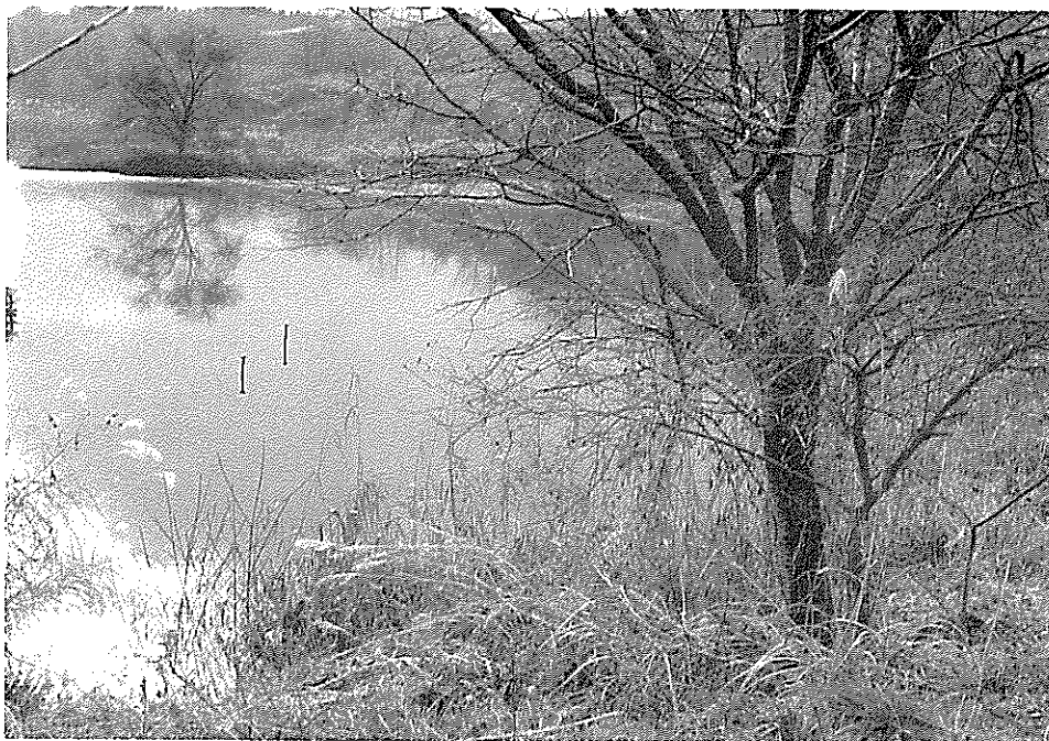
写真6. 貯留・浄化用の池。複合ラグーン法により処理された後、汚水が最初に放流される池。余剰汚泥が大量に沈積するため、5年毎に浚渫を行っている。前回は平成9年春と間もないことから、池の中には藻類等を除き、湿地特有の植物は生育していない。また、水深も3mから5m程あり、人工湿地としての浄化機能は高くない（宮城県高清水町）。
