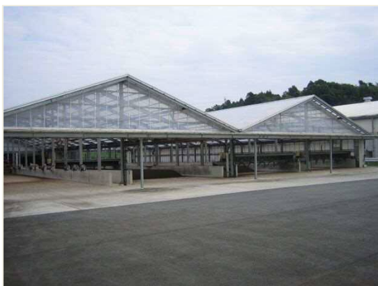
写真10 4連浅型攪拌機型乾燥棟 (夏場は15日、冬場は40日前後で水分量を10%以下まで下げることができる。)
