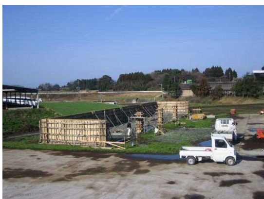
写真1 新たに整備中の処理施設
