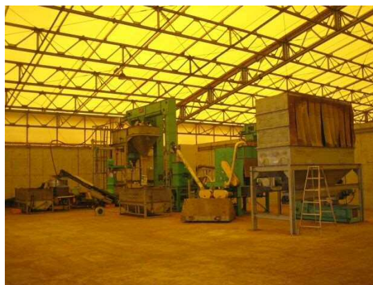
写真11 高圧縮型大型堆肥ペレットマシン (風力選別機での異物除去、粉碎処理の後、高圧縮をかけ成型する。)
