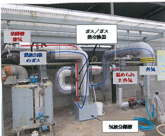
図1 クロスパイプ式熱交換器の外観
