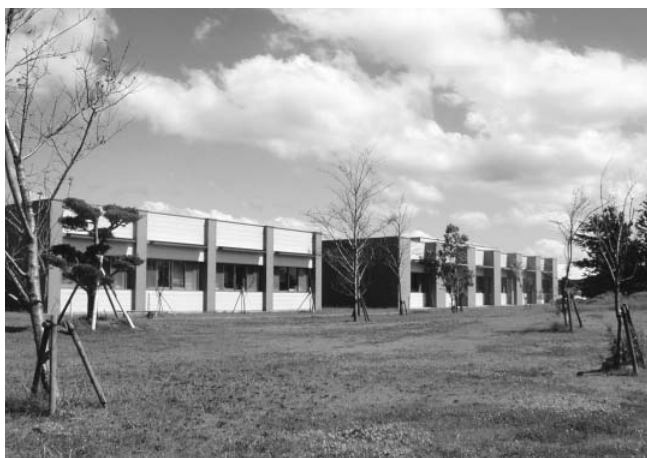
鹿児島県農業開発総合センター畜産試験場の研究棟
