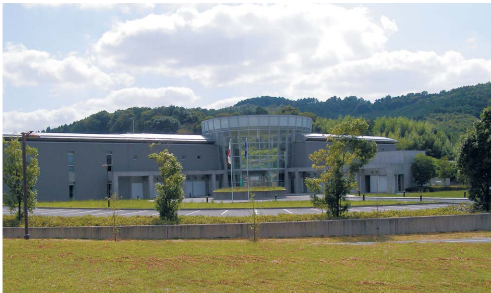
畜産センター本館
