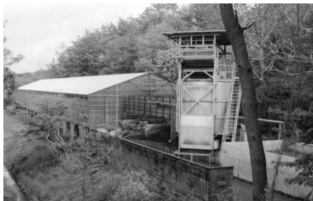
写真1（左から）たい肥舎、密閉式コンポスト、脱臭槽
