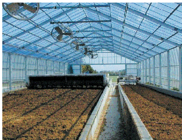
軽量鉄骨ビニールハウス発酵・乾燥施設
