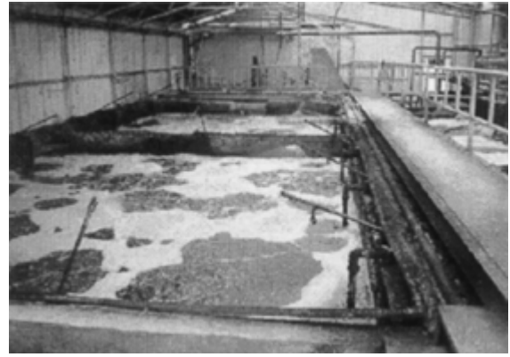
活性汚泥による浄化処理(養豚農家)
