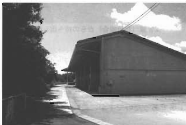
生産組合の保管庫（養生施設）
