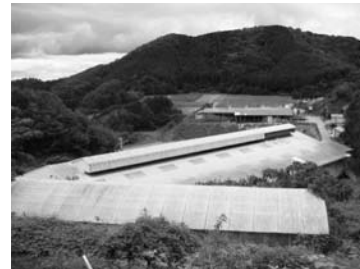
写真2 土づくりセンターの全景
