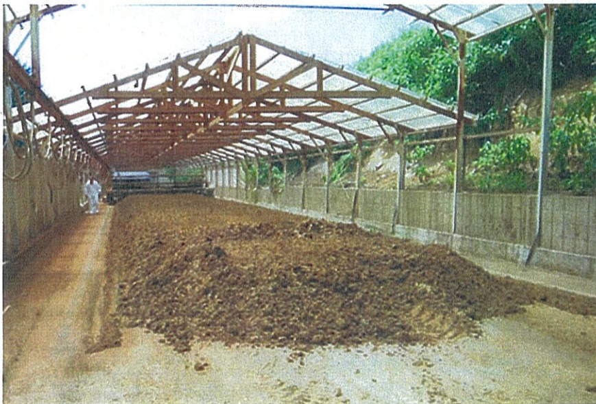
写真3 ロータリ攪拌式のハウス型発酵施設
