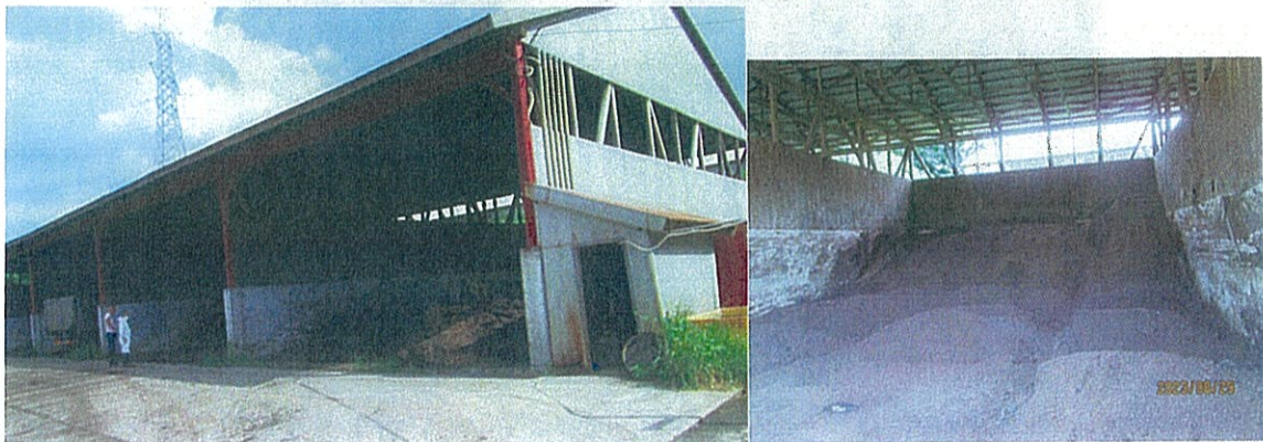
写真3 堆肥舎(製品貯蔵庫)(左)、放熱中の堆肥(右)
