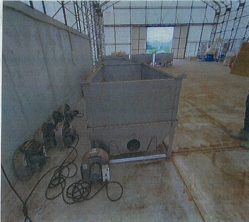
写真8 乾燥コンテナ、手前の送風機をコンテナ下部に挿入して乾燥する
