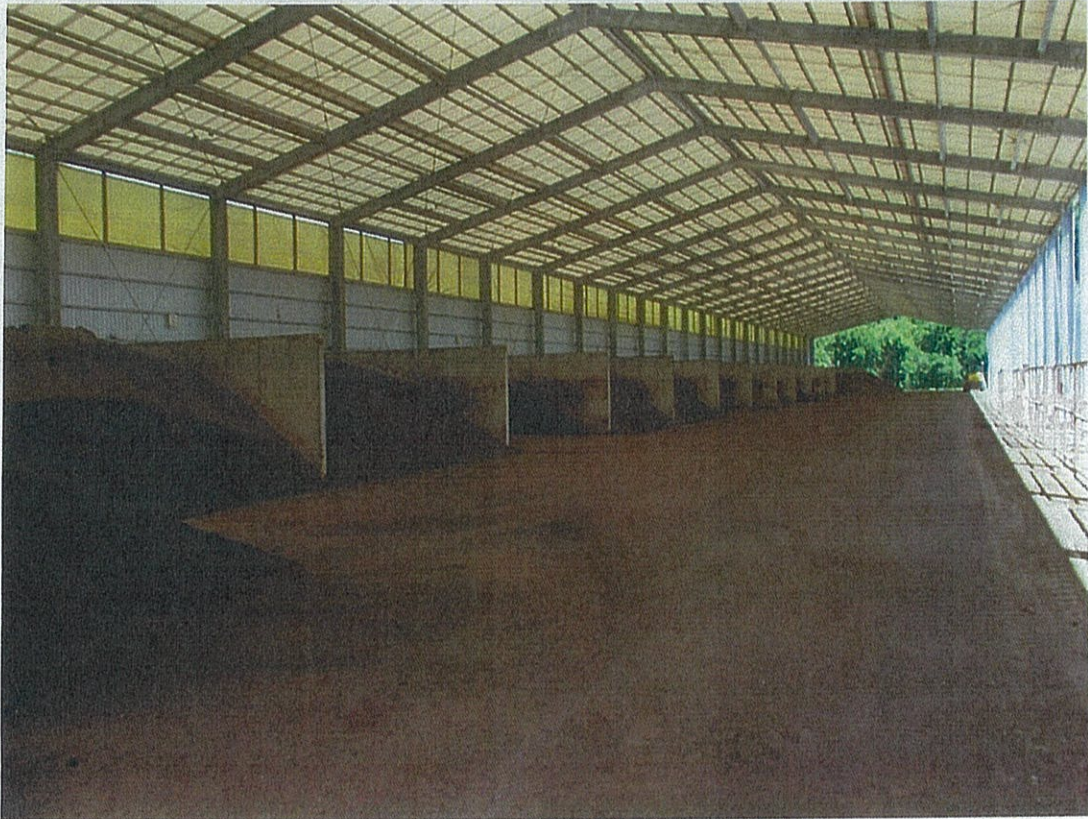
写真3 一次発酵ピット(堆積方式の通気型堆肥舎)
