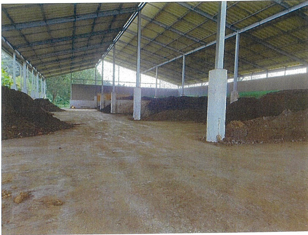
写真2 堆肥舎1内観(北側の出入口付近より撮影)
