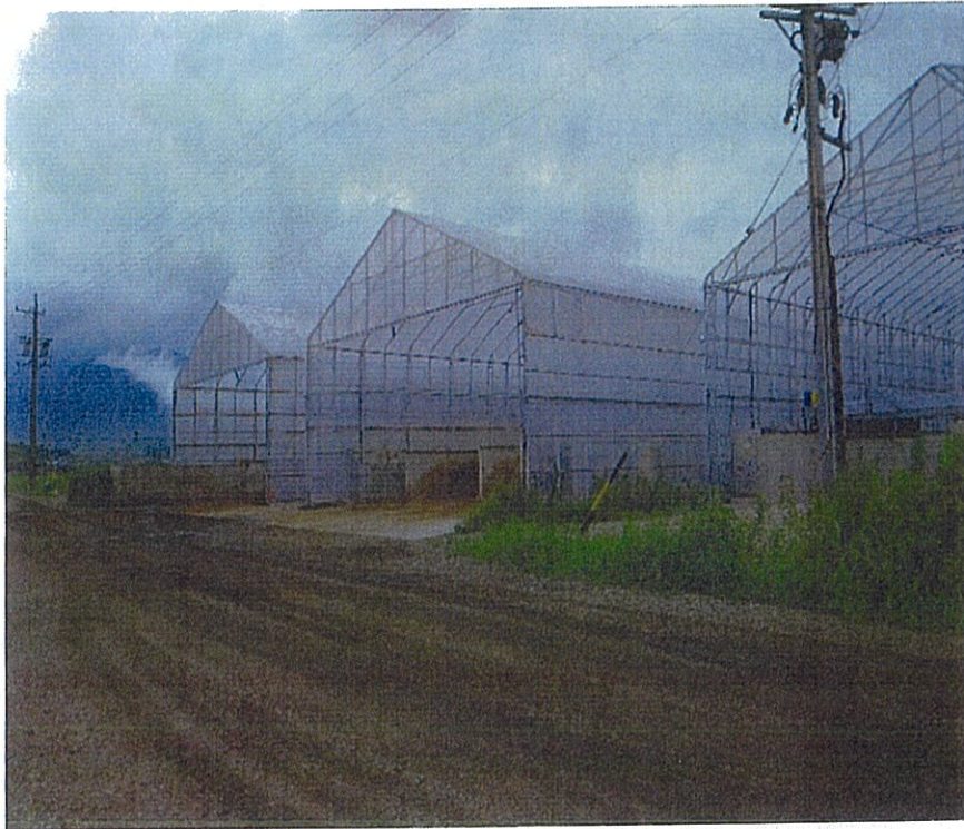
写真2 ロータリー式堆肥化施設
