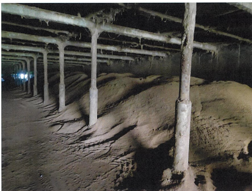
写真5 堆肥舎(養生槽)
