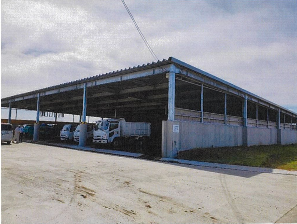
写真1 堆肥舎の全景
