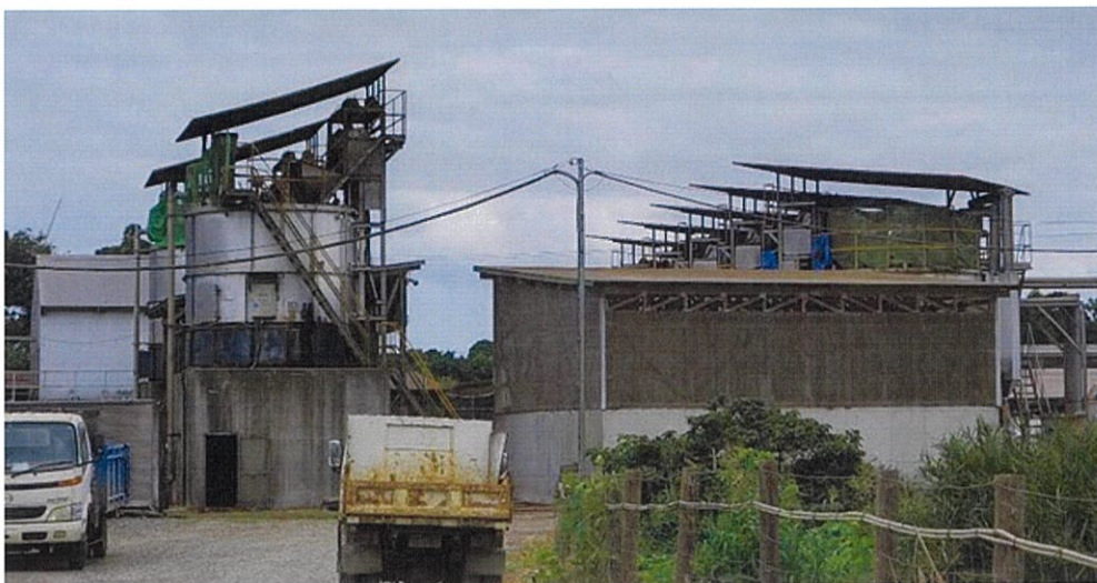
写真2 コンポの設置状況
