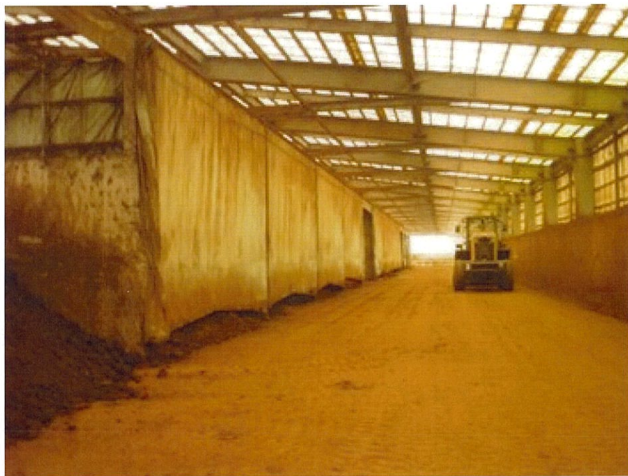
写真3 通気型堆肥舎 前面カーテンで防臭
