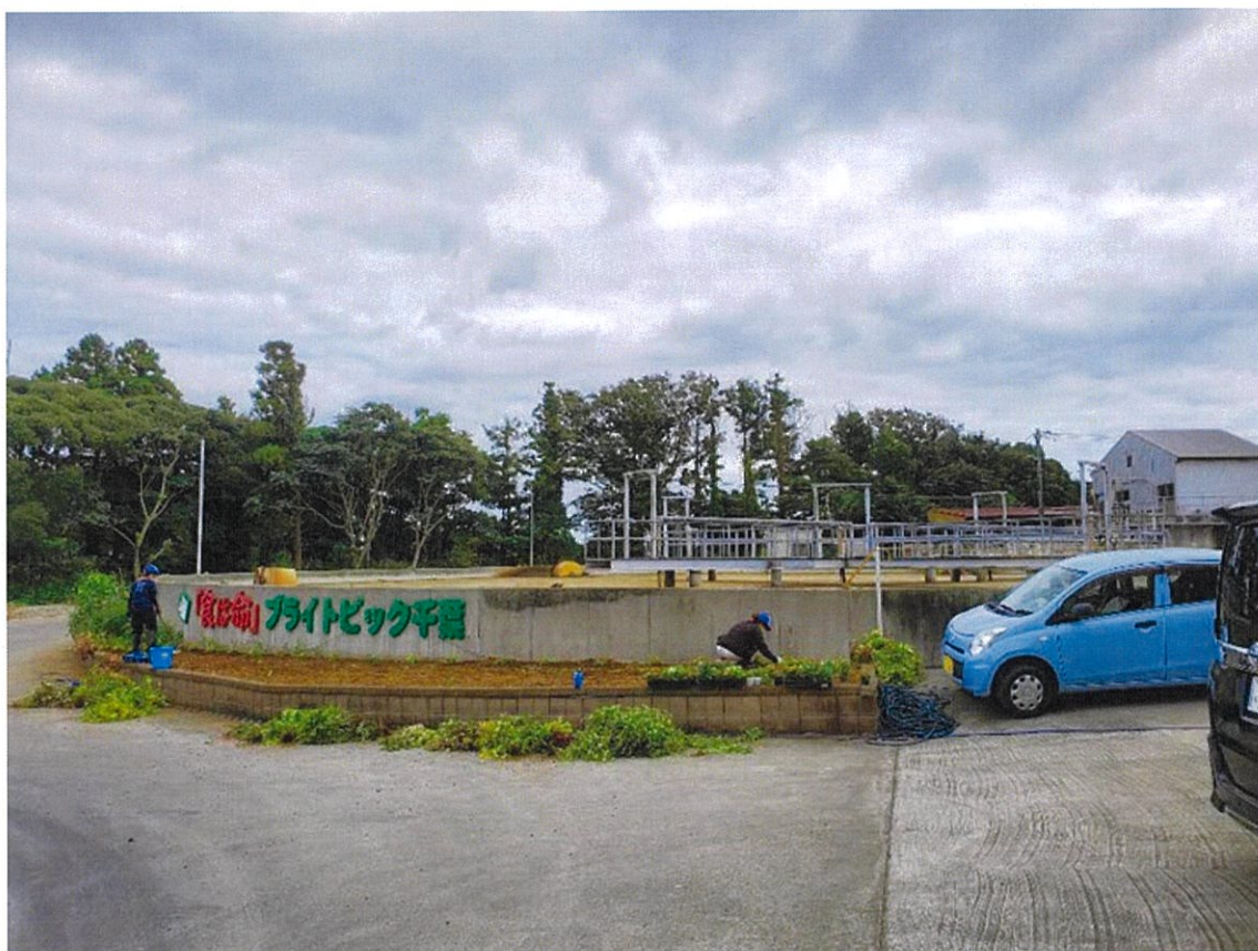
写真3 複合ラグーンを設置状況
