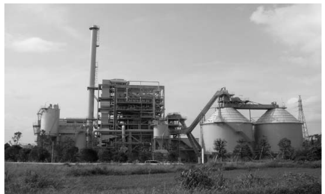
みやざきバイオマスリサイクル株式会社（MBR） 【鶏ふん焼却発電施設】
